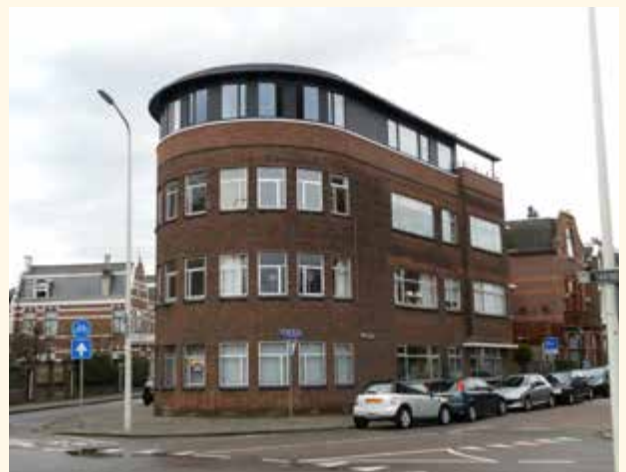
Dakopbouw hoek Pansierstraat - Cornelis Jolstraat
