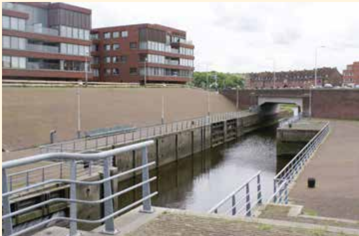
Deze schutsluis wordt niet meer door schepen gebruikt, alleen maar door overtollig water
