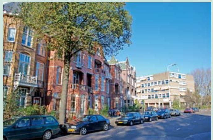
Zo moet het niet. Deze betonblokken detoneren bij de vloeiende lijnen van Duinoord. Foto René Vlaanderen
