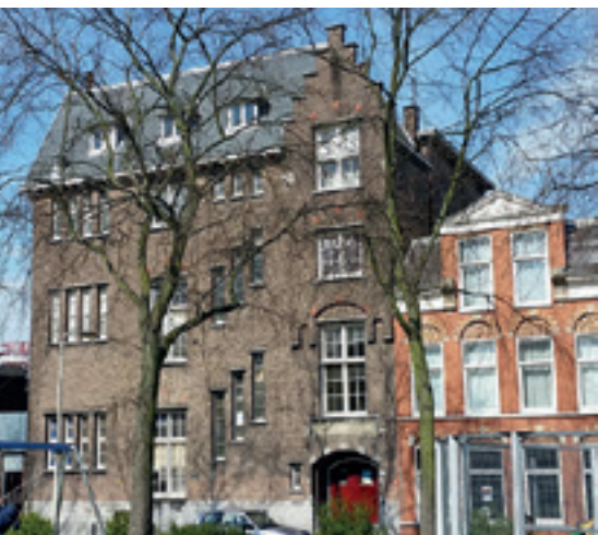
Voormalige school Teniersstraat
