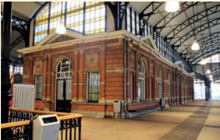
Gebouw met wachtkamers en restauratie op het perroneiland
