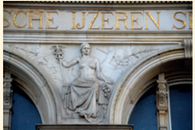
Detail van het centrale deel van de gevel boven de hoofdingang
