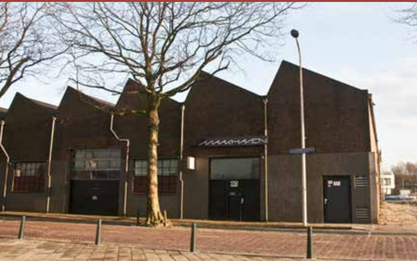
Het sheddak van de zijkant
