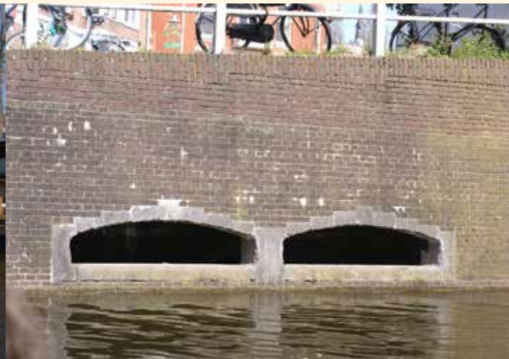
Via deze overstort komt vuil water in het kanaal
