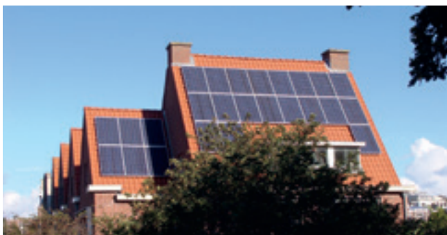
Mooi is anders. Traditionele zonnepanelen op een huis aan de Nieuwe Duinweg, Den Haag (foto Jacob Bijl)
