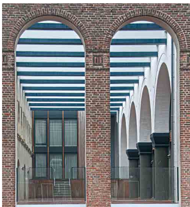
De Onze Lieve Vrouw van het Allerheiligst Sacrament, een voormalige rooms-katholieke kerk aan de Grovestinsstraat in Moerwijk-Zuid, is van een sombere, al jaren leegstaande kerk omgetoverd in een zonnig wooncomplex (foto Casper de Weerd)
