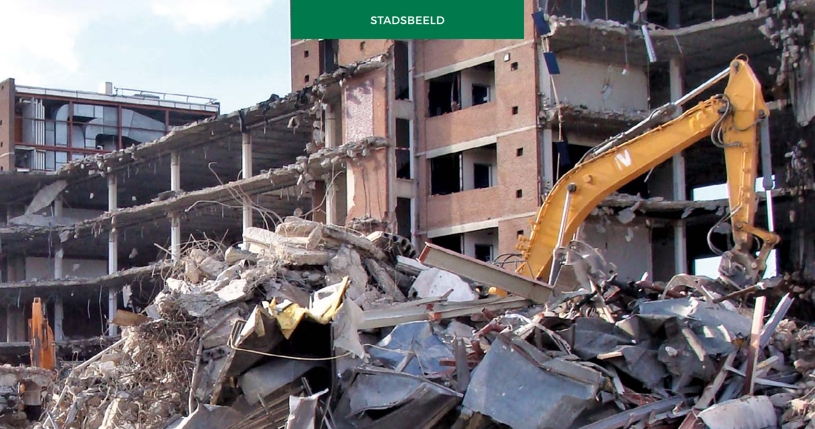
Sloop van een kantoor dat nog niet eens zo oud is
