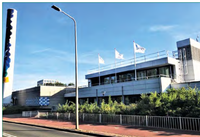
Afvalwateringszuiveringsinstallatie van Delfland, Houtrustweg (foto Jan Nicolai)
