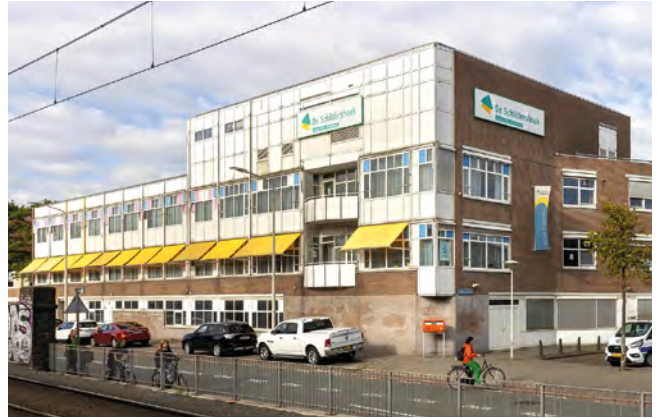
De gevels van het voormalige verpleeghuis De Schildershoek aan de Parallelweg zijn opgebouwd uit een combinatie van baksteen en trespavegelplaten (foto Dick Valentijn)
