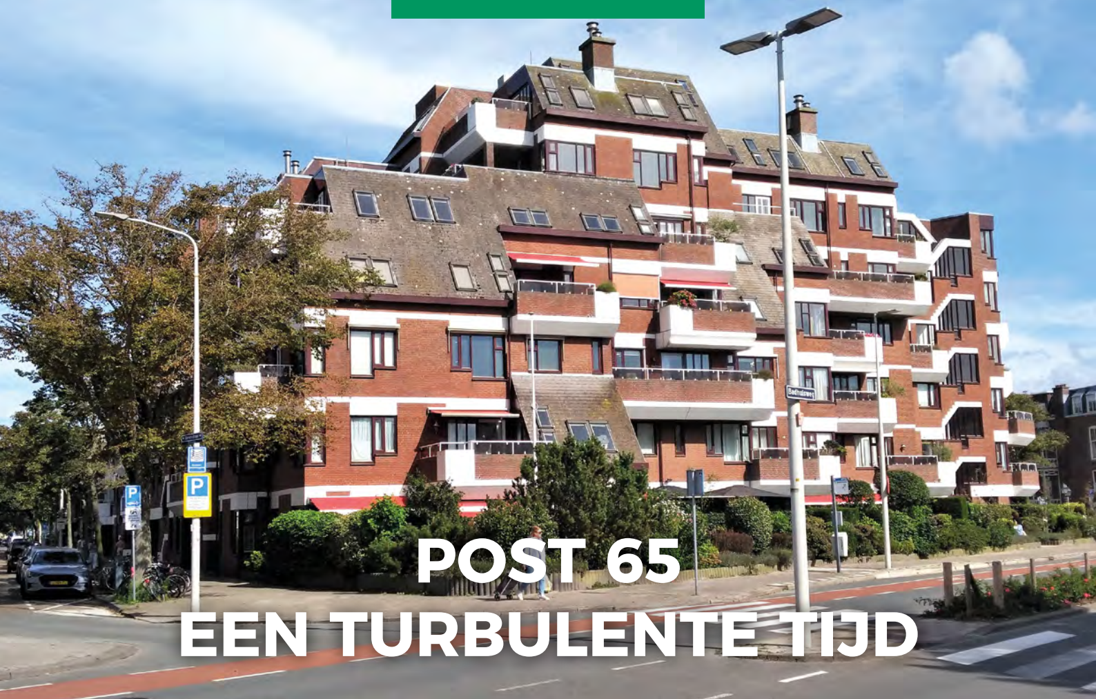
'Schuin en bruin' aan de Badhuisweg, hoek Stevinstraat (Architect A. Bonnema, 1979) (foto Jan Bron Dik)
