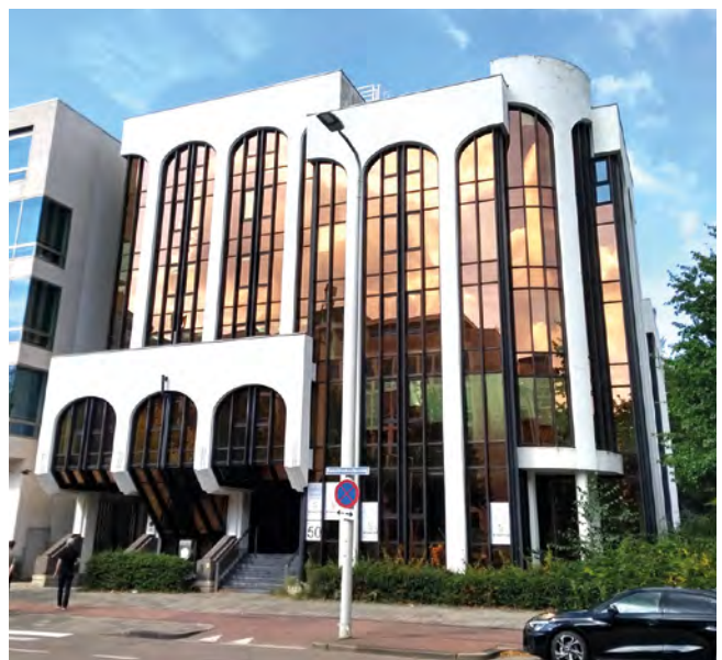
Kantoorpand Bohemenhuis. Gevel van beton in combinatie met glas, typisch Post 65 (Mehrtens & Van Veldhoven Architecten, 1979-1982) (foto Jan Bron Dik)
