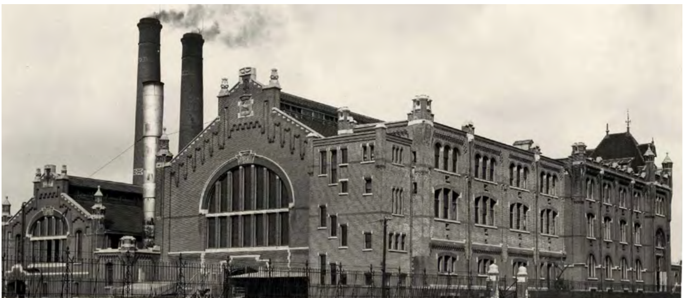
In 1901 besluit de Haagse gemeenteraad de elektriciteitsvoorziening in eigen beheer te nemen. De eerste Haagse stroomcentrale uit 1889 van Siemens aan de Hofsingel mag niet verder uitbreiden. Het Gemeentelijk Electriciteitsbedrijf (GEB) wordt gebouwd op het Kleine Veentje, een onbebouwd terrein van volkstuinten net buiten de singels (foto Stichting Haags Industrieel Erfgoed (SHIE))
