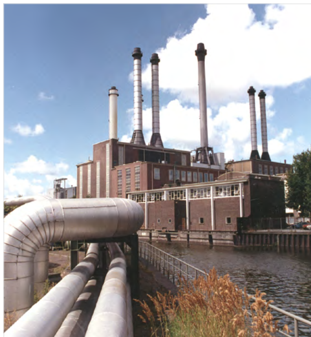
Leidingen en schoorsteenpijpen van de stadsverwarming (foto Haags Gemeentearchief)
