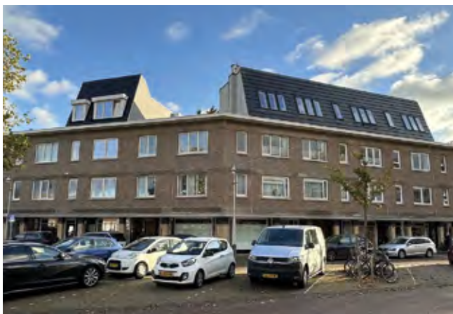
Dakopbouwen Thomsonplein met dakkapellen en Thomsonlaan met dakramen. Hoe moet dit ooit een eenheid worden? Foto: Maarten Ruijters
