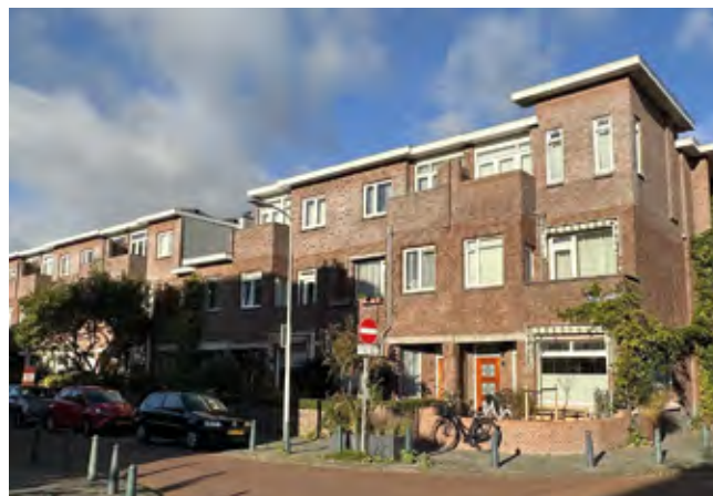
Primulastraat. Een geslaagd voorbeeld van optoppen met een derde laag. De plasticiteit blijft behouden, wordt zelfs versterkt door dakopbouw. Architect Otto Das. Foto: Maarten Ruijters
