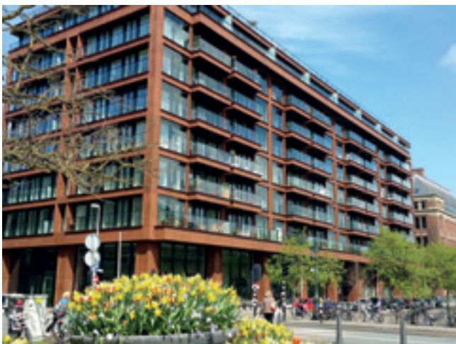
Kantoor omgebouwd tot woningen (Kortenaerkade)
