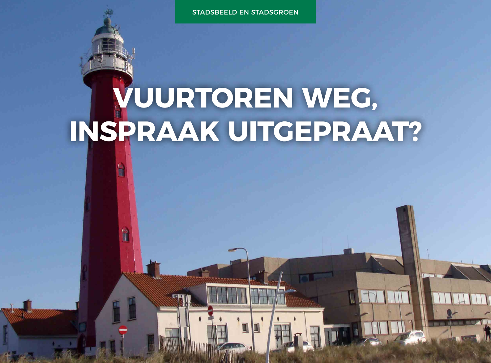
Vuurtoren gezien vanaf het strand, rechts het te vervangen gebouw
