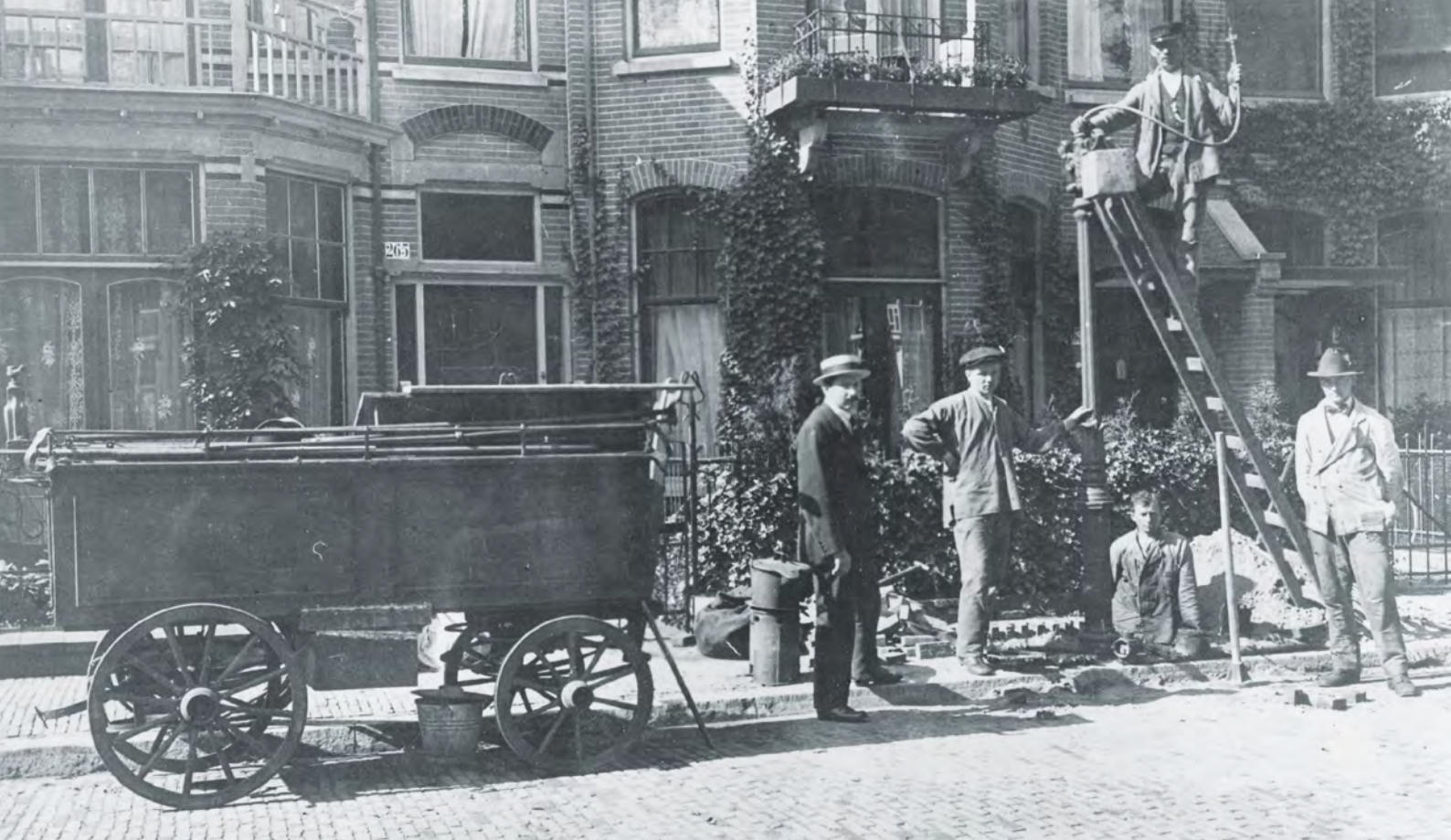
Laan van Nieuw Oost-Indië. Ombouw van de gaslantaarns naar elektrische verlichting, 1919 (foto 100 jaar Centrale Den Haag)
