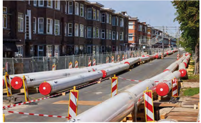
Aanleg leiding warmtetransportnet in Den Haag (foto warmtelinq.nl)
