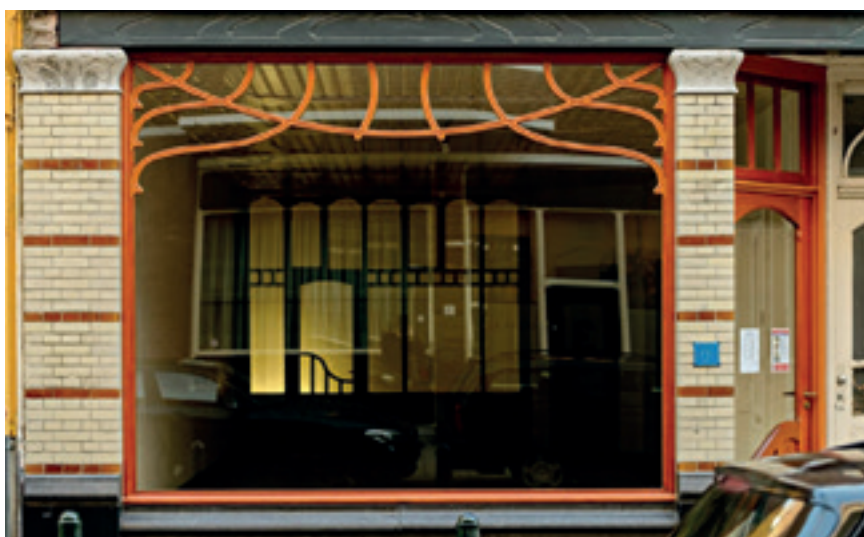
Pand Piet Heinstraat 2b – exterieur voor en na restauratie
