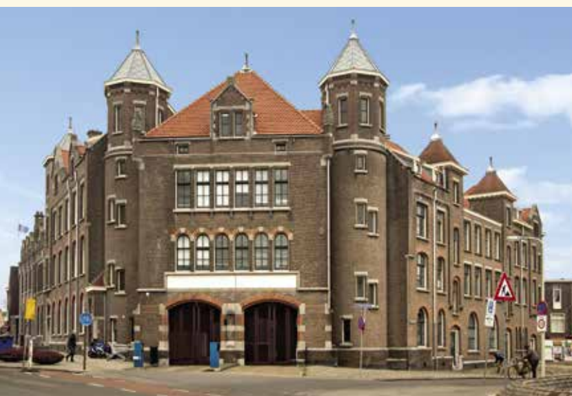
Voormalige brandweerkazerne annex politiebureau in de Duinstraat
