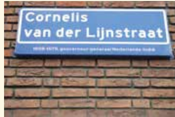
Noors verband: twee strekken afgewisseld met één kop en de koppen om en om boven elkaar
