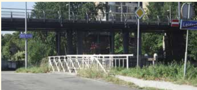
Jaagbrug aan de Delftse Vliet bij station Leidschendam-Voorburg
