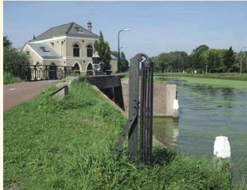
Rolpaal en jaagbrug bij het monumentale stoomgemaal en de herberg Vlietzicht tussen Hoornbrug en Delft
