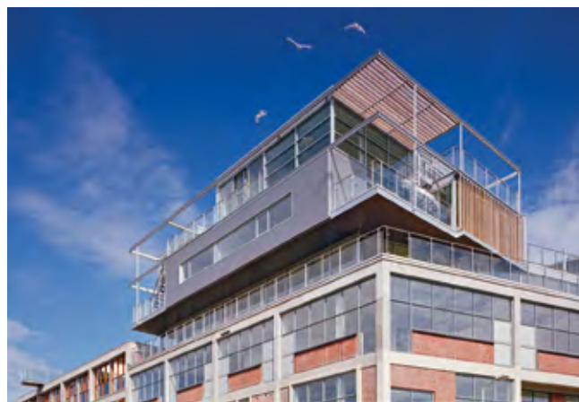
Transformatie pakhuizen Nautilus en IJsvij, Scheveningen haven, met diverse woningen op het dak, door Archipelontwerpers, 1998-2005. Foto: Eric Vreedenburgh
