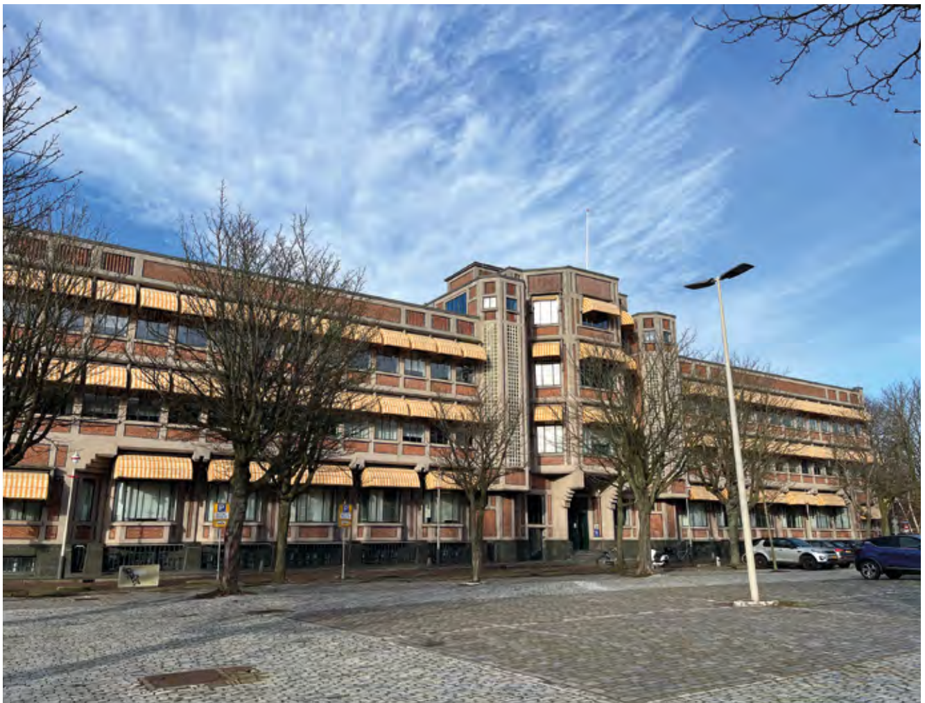
Extra dakverdieping door Dudok, 1954 op een gebouw van Berlage, 1921-1927. Foto: Eric Vreedenburgh
