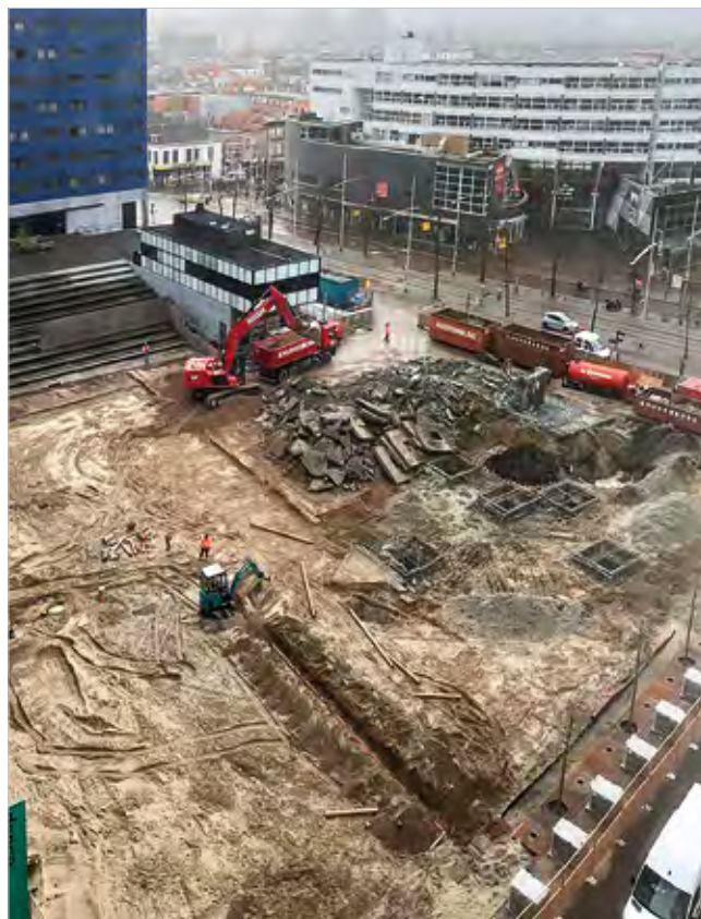
Sloop van pompkelders waterwerk. Foto: Albert Koolma
