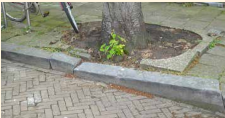
Gebroken stoeprand van blauw hardsteen in de Van der Capellenstraat (Bezuidenhout-Oost) (foto Martin Snuverink)
