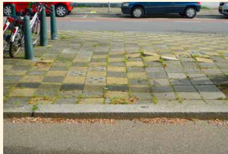
Granieten trottoirbanden op de Juliana van Stolberglaan bij het Stuyvesantplein (foto Martin Snuverink)
